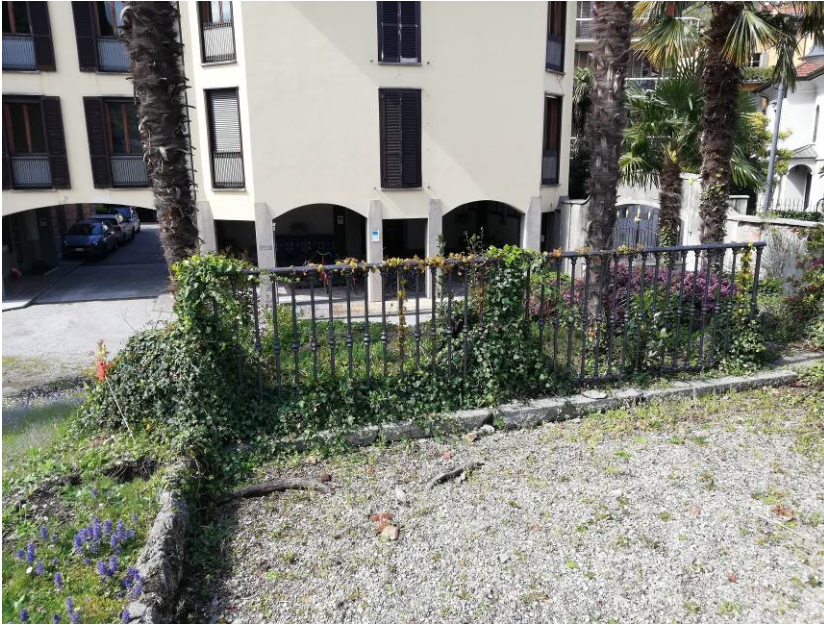
Balaustra sopra all'ingresso.
