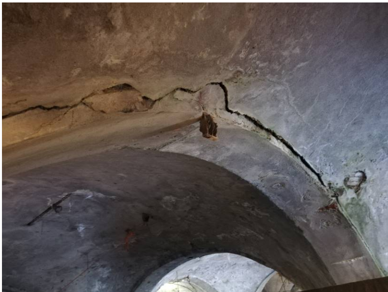
Lo stato critico strutturale si può evincere da questa fotografia (si rimanda alla tavola specifica)
