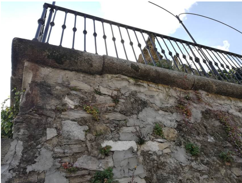
La cornice in sasso e la balaustra di testa al muro.
