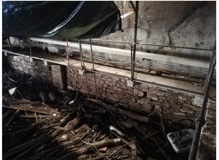
Il camminamento in lato dex su mensole in sasso.
