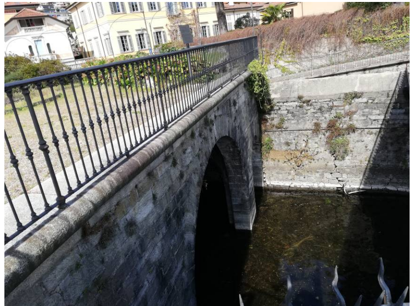
La balaustra sopra all'arcata di ingresso darsena.
